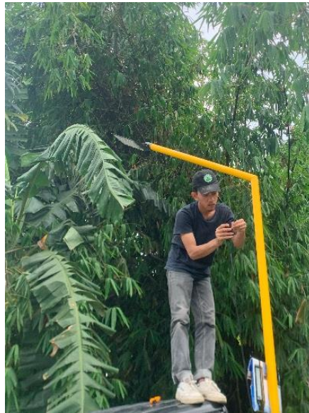
Gambar 4. Proses Instalasi Kabel Antartiang
